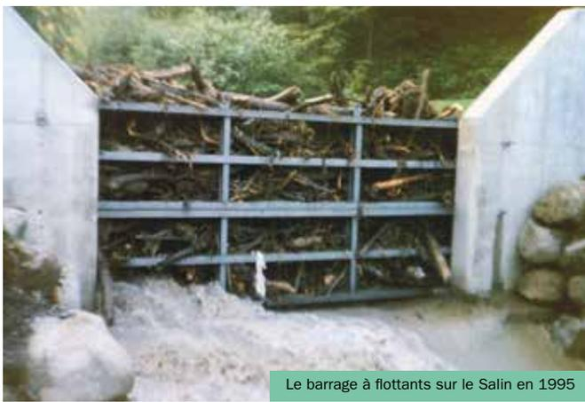
Le barrage à flottants sur le Salin en 1995
