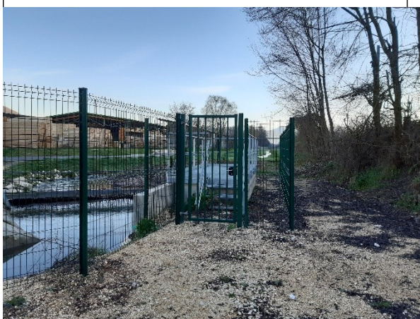
Vannes du Renevier – portail d'accès à la plateforme de manutention des vannes
