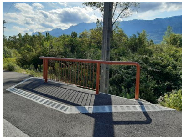
Chicane et garde-corps sur le chemin du Vernay
