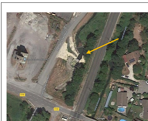
Vannes du Renevier - localisation
