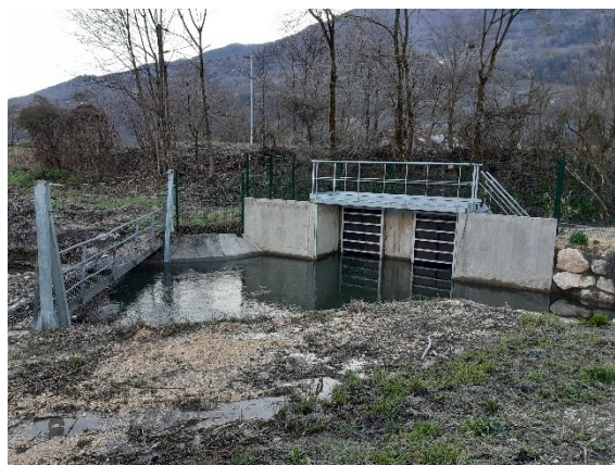
Vannes du Renevier – vue amont
